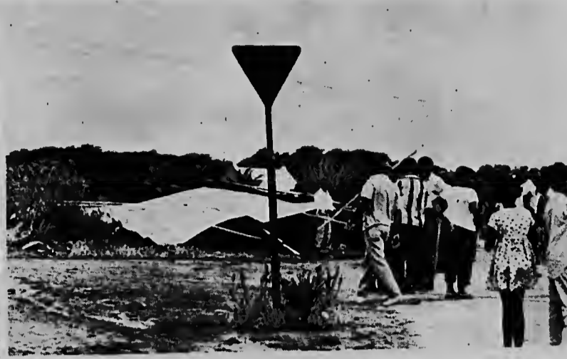
Na momento cu e dak tabata den halto ela kibra algun waya di electricidad den e vecindario. Lo mas penoso ta, cu apenas dos siman pasa e dak aki a ser pone, despues cu e cas a hanja un renobacion completo.
